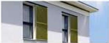
L'adozione di elementi fotovoltaici in facciata, trattandosi di edifici molto alti e ravvicinati, richiede la verifica dell'ombreggiamento che ciascun edificio determina sugli altri.
